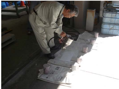
酸化チタン吹付け
