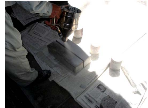
蓄光材吹付け
